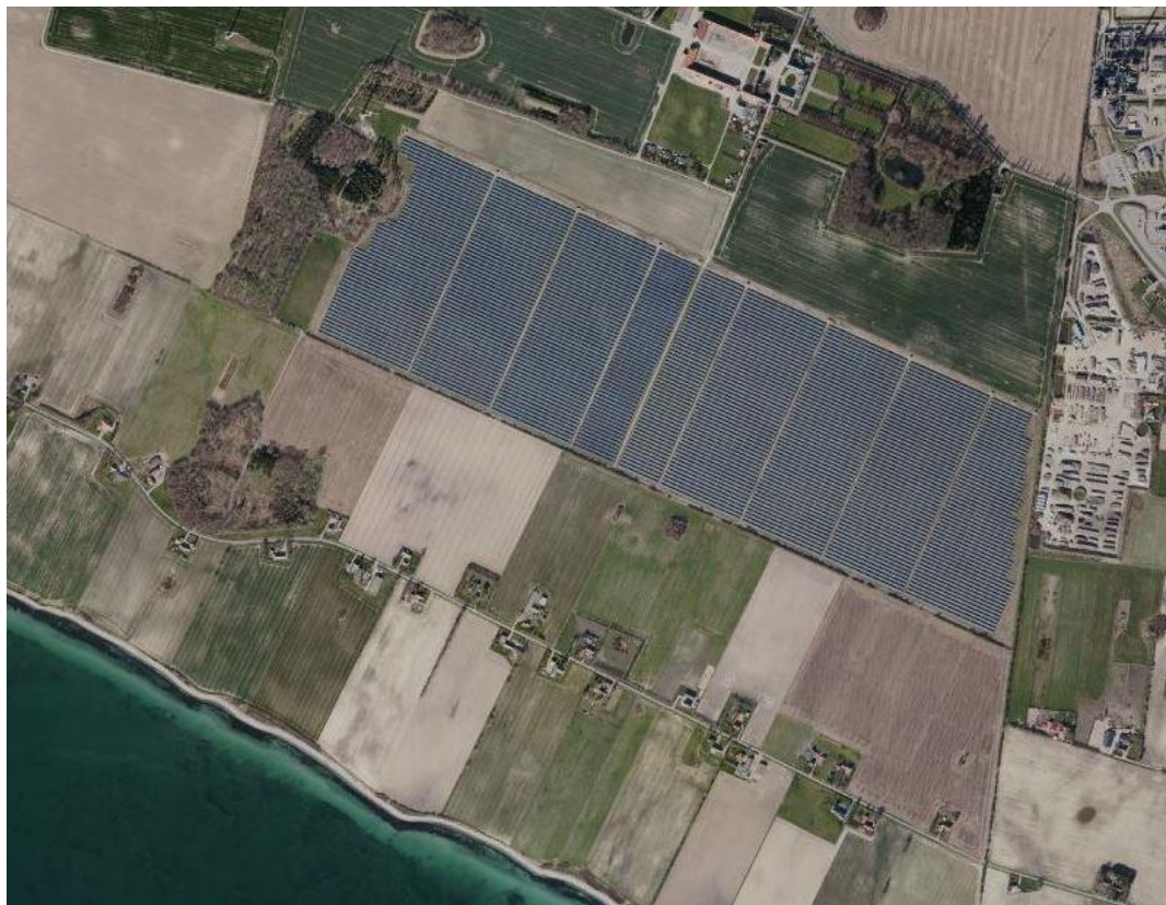
Foto: Solenergianlægget ved Lerchenborg set oppe fra.
